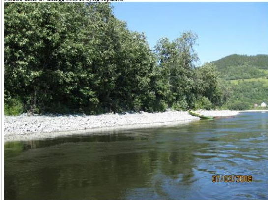
Nedre deler av anlegg som er nylig reparert.
