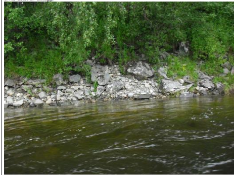
Midtre deler av anlegg.
